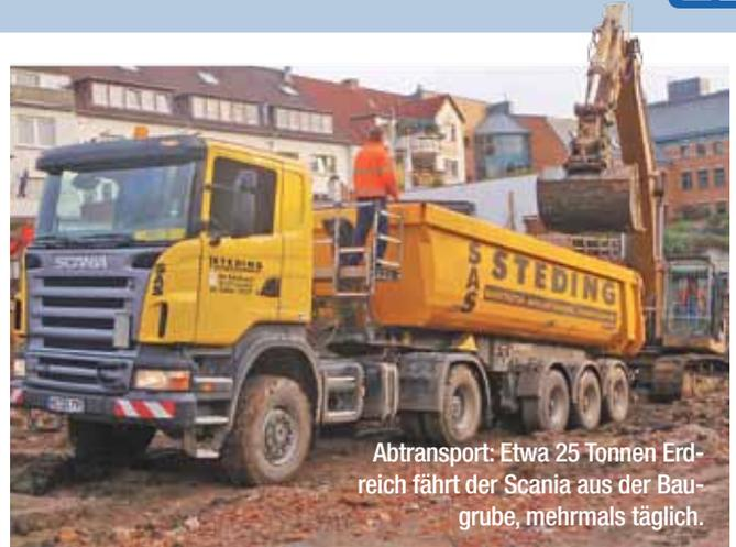
Abtransport: Etwa 25 Tonnen Erdrreich fährt der Scania aus der Baugrube, mehrmals täglich.
