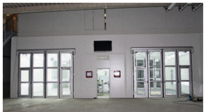
Das Herzstück der Werkshalle: zwei Sehon Kombi-Kabinen mit Lackier- und Trockenräumen. In der Mitte befindet sich der Farbmischraum.
