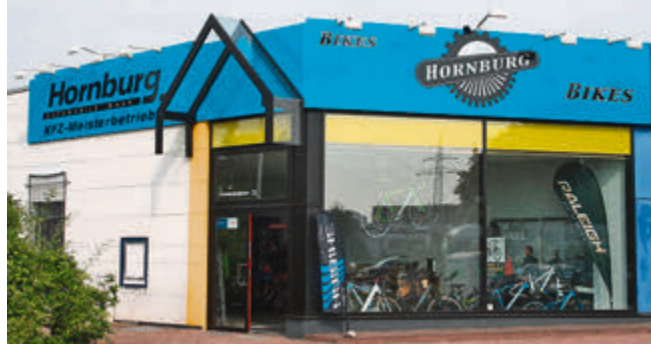
Auffällig: Die neuen Hornburg-Räumlichkeiten liegen in exponierter Lage, Kreuzung Kennedydamm/Bavenstedter Straße.
