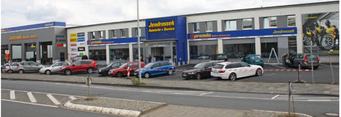
An der Bavenstedter Straße hat die Firma Jendrossek die wahrscheinlich größte freie Werkstatt Norddeutschlands errichtet.
