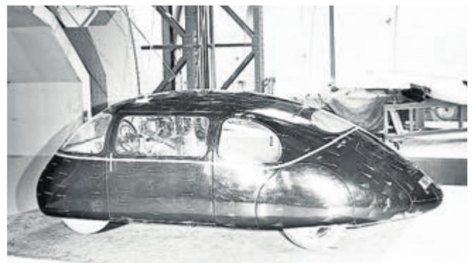
Ab 1936 verfügte die AVA bereits über einen Groß-Windkanal, in den der fertiggestellte Schlör-Wagen hineingehängt wurde, um die Luftströmung am Fahrzeug sichtbar zu machen.
