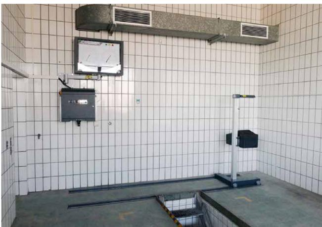
Eine der geplanten Prüfstraßen mit Grube und Bremsenprüfstand.
